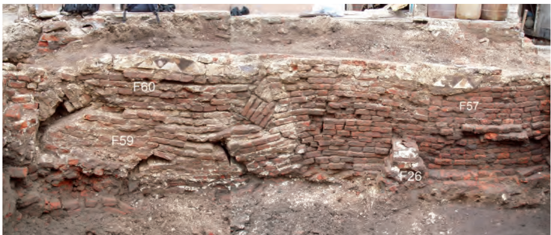
Afb. 6.1. Het hier afgebeelde muurwerk bevindt zich boven en in de lengterichting van de voormalige greppel. Te zien is hoezeer al het muurwerk in de losse vulling van de greppel is verzakt (foto genomen richting het westen). Het muurwerk is ook te zien op bijlage 7; Z-N profiel.
